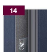
Uszczelka pęczniąca [drzwi PPOŻ]
